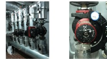
Größtenteils überdimensionierte Leistungszapfen vorhanden Kleinere Zapfen für kleinere Standorte
